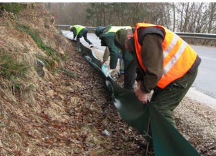
Postavljanje ograje za dvoživke
